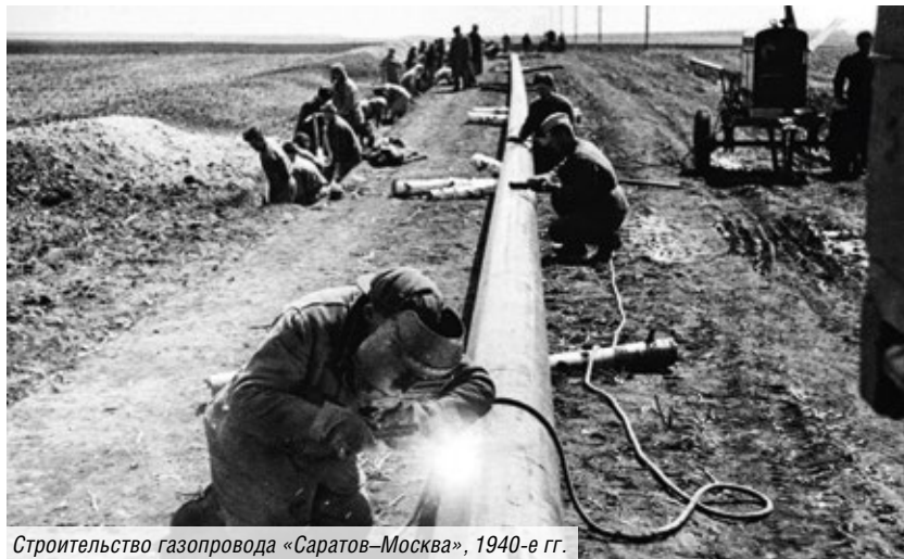
Строительство газопровода «Саратов–Москва», 1940-е гг.
