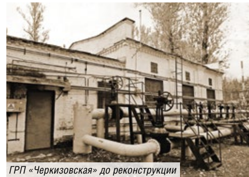
ГРП «Черкизовская» до реконструкции
